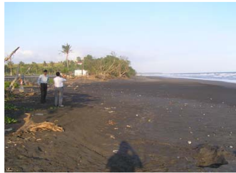
Gambar 2.12c Kondisi Biofisik yang rusak akibat abrasi pantai di Pantai Pengambangan
