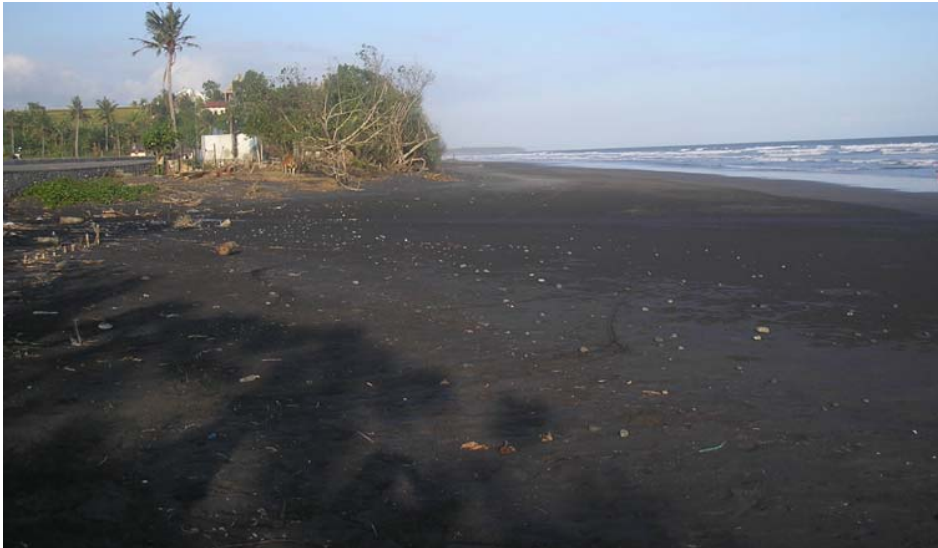
Gambar 2.8. Kerusakan Bio Fisik Pantai Pengambangengan
